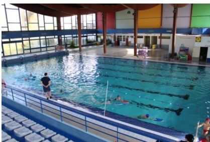
Grand bassin de la piscine du Raincy
